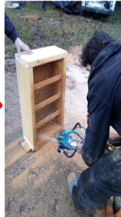
La conductivité thermique du mélange terre/chanvre est :  $\lambda$  terre/chanvre : **0,09 W/m.K** soit une résistance thermique pour les 22cm d'épaisseur : **R = 2,44 m<sup>2</sup>.K/W**.
