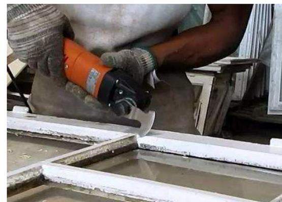
Démantèlement des fenêtres : séparation du châssis et du verre
