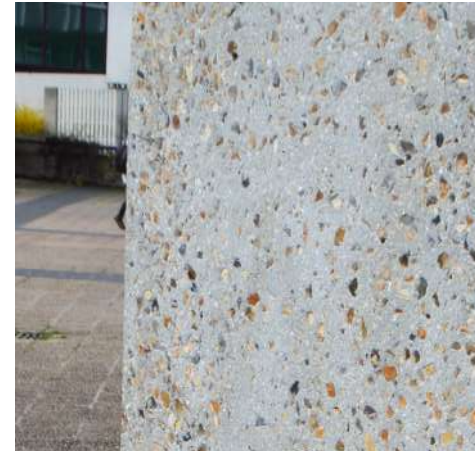
surface lisse faisant apparaître les granulats
