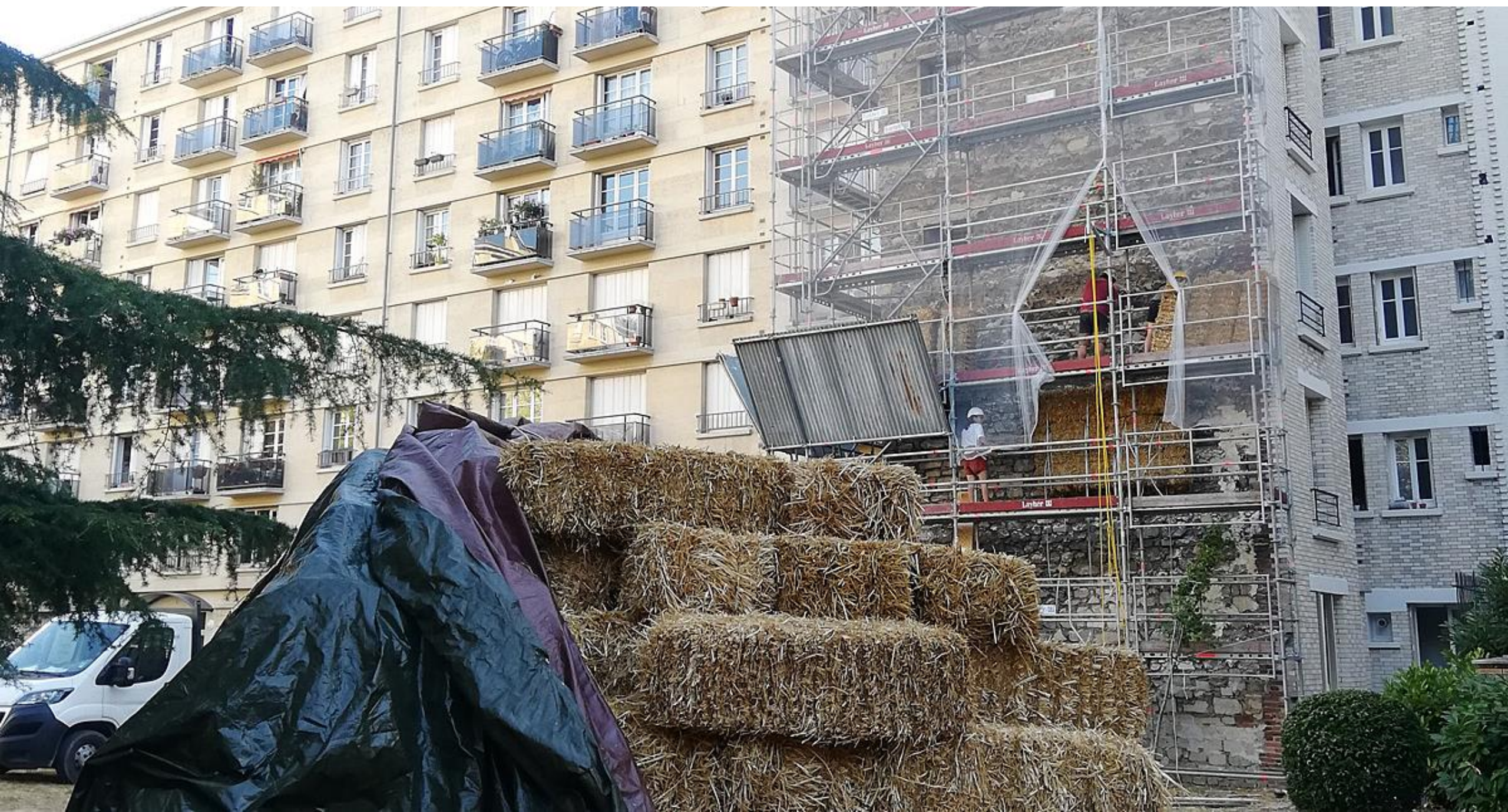
Isolation Thermique par l'Extérieur à Paris 15 ème – architectes : Landfabrik et Trait Vivant – crédit photo : Paris Habitat
