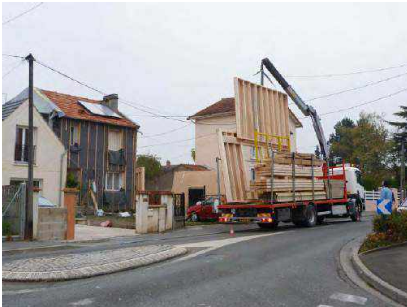
Maison Dado, Grutage et Mise en Oeuvre Plancher Bas sur place
