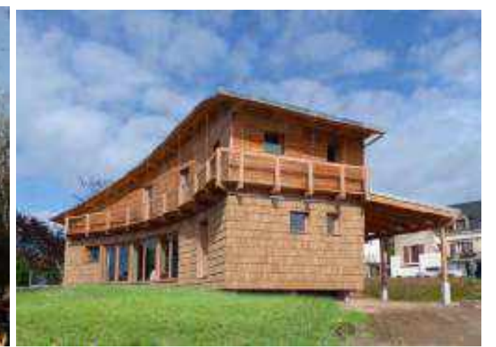
Maison Kima / murs, pb et toit en préfabriqués / 2014, Trait Vivant Architecte
