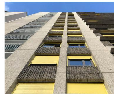
Parements de béton architectonique après hydrogommage
