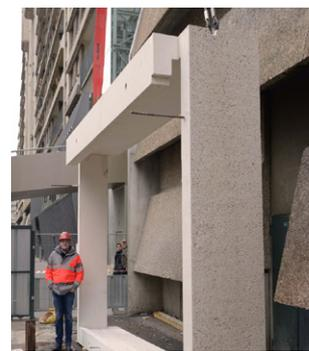
Manutention du cadre préfabriqué de 9 tonnes pendant le chantier
