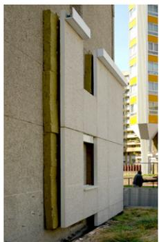
Isolation thermique par l'extérieur des murs pignons en chantier
