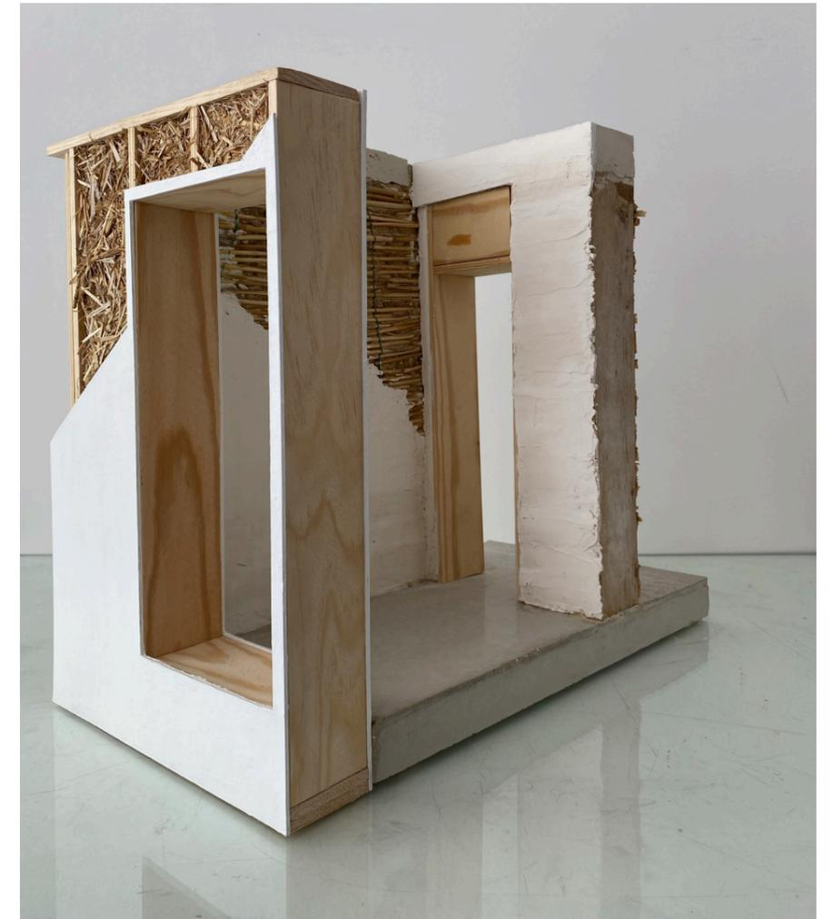
Maquette réalisée à l'agence : ossature porteuse poteau/poutre et dalle en béton / murs intérieurs en terre coulée / façade ossature bois et isolation paille
