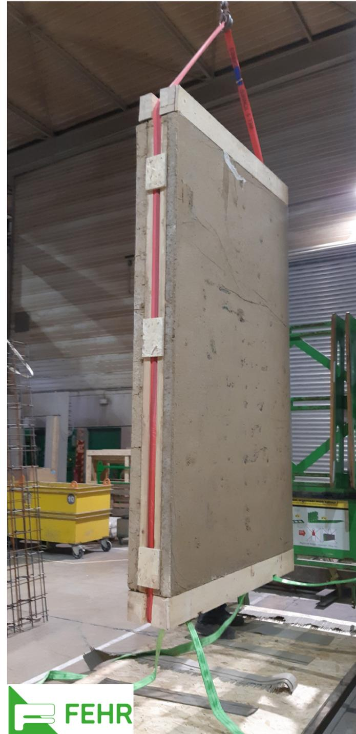
Levage du prototype du mur en terre coulée dans les usines de l'entreprise Fehr
