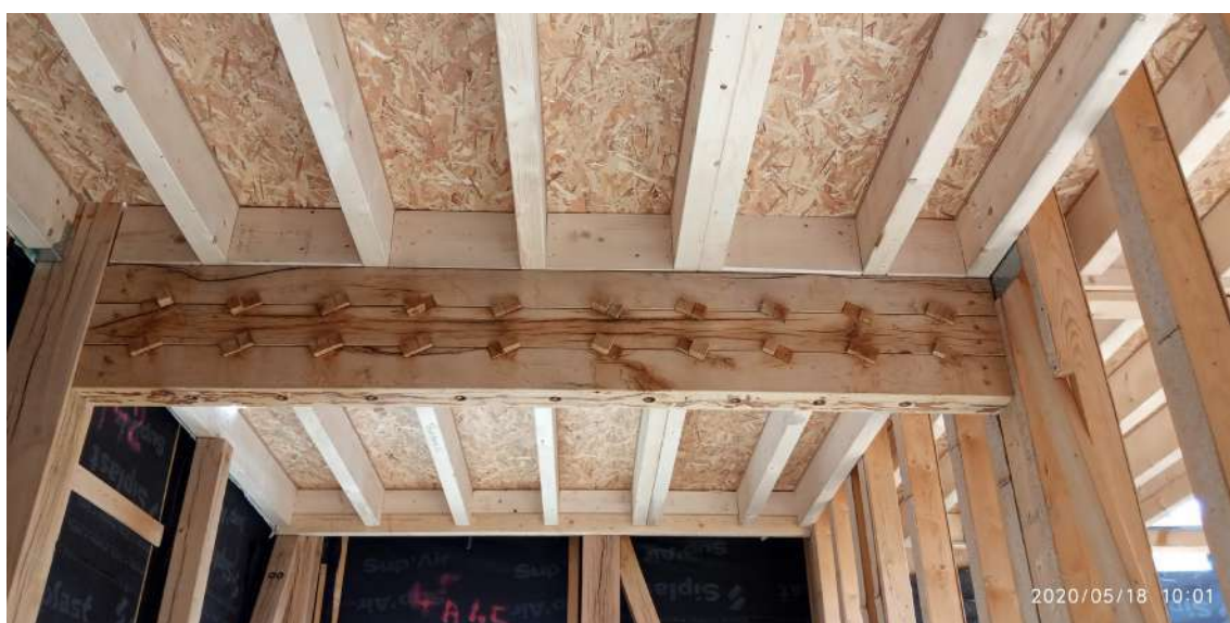
Poutres clavetées. Groupe scolaire Simone Veil.
