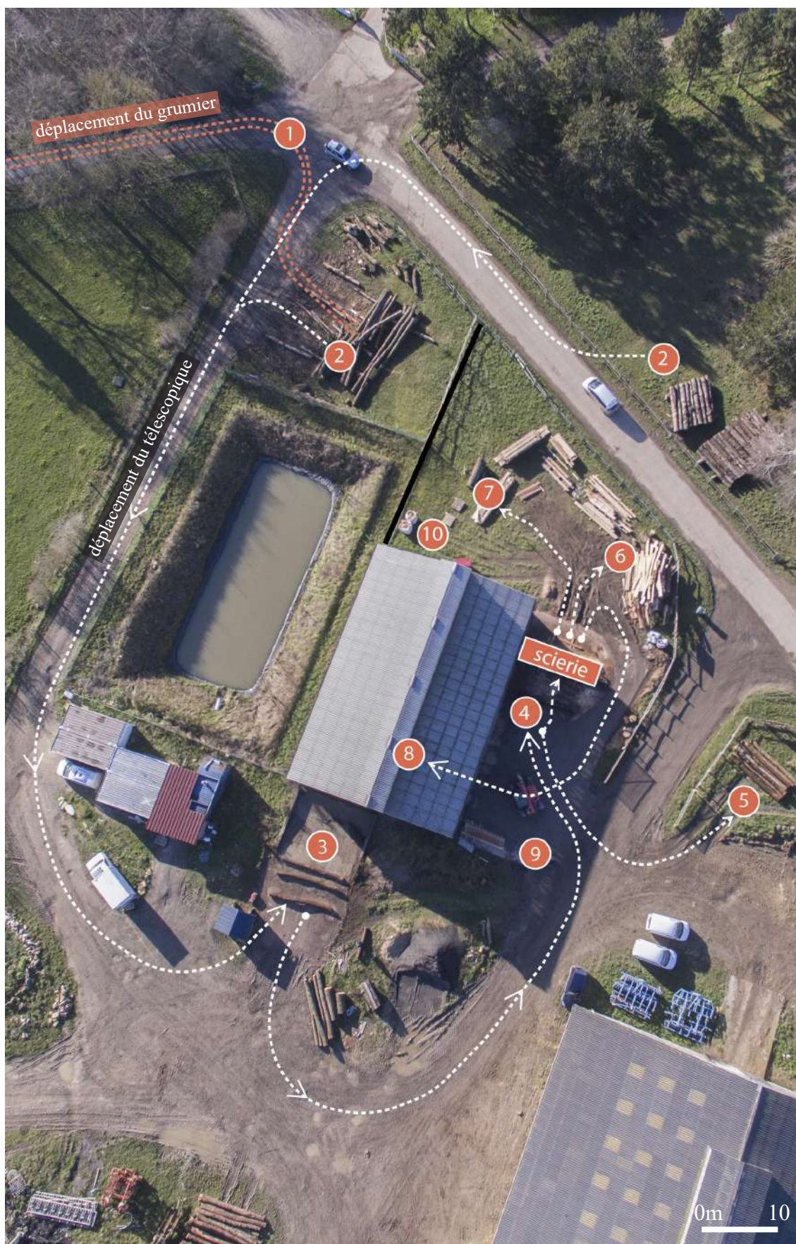
Vue aérienne du chantier de sciage. Chaussy (Val-d'Oise). Janvier 2020. © Juan Sepulveda
