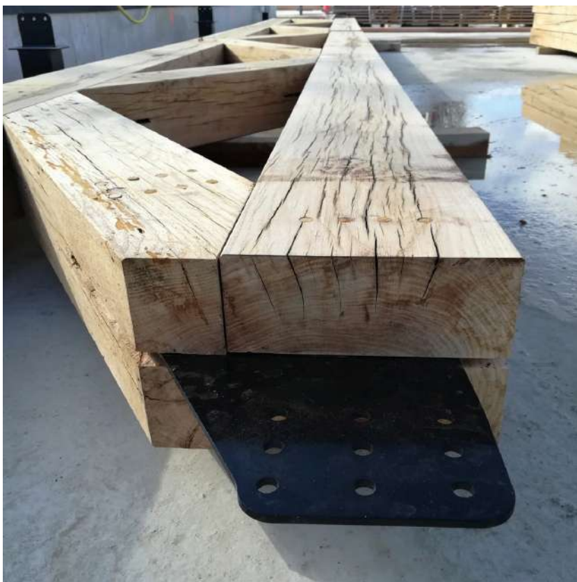
Groupe scolaire Rosny Métropolitain . Poutres treillis en chêne massif. Phase chantier. Février 2020. © Ville de Rosny-sous-Bois
