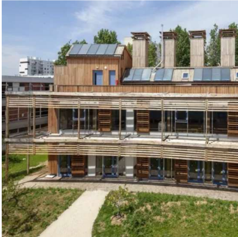
Groupe scolaire Simone Veil . Rosny-sous-Bois. © Ville de Rosny-sous-Bois
