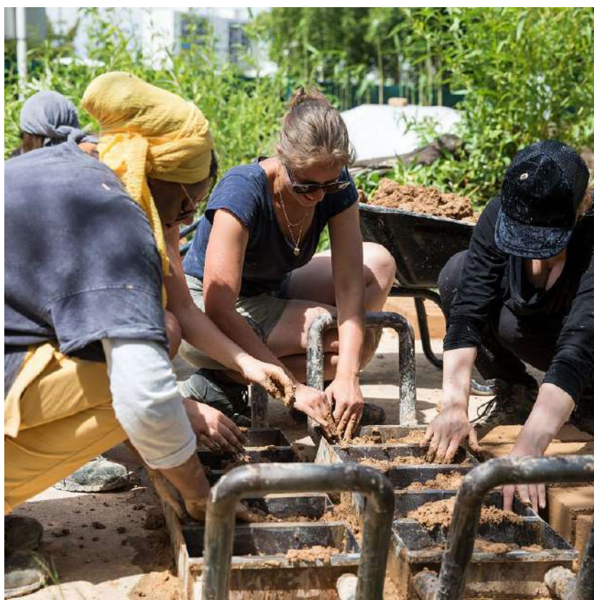
Chantier terre crue, briques (adobes). Chantier participatif citoyen. Rosny-sous-Bois. Juillet 2020. © B. Guigou - Rosny
