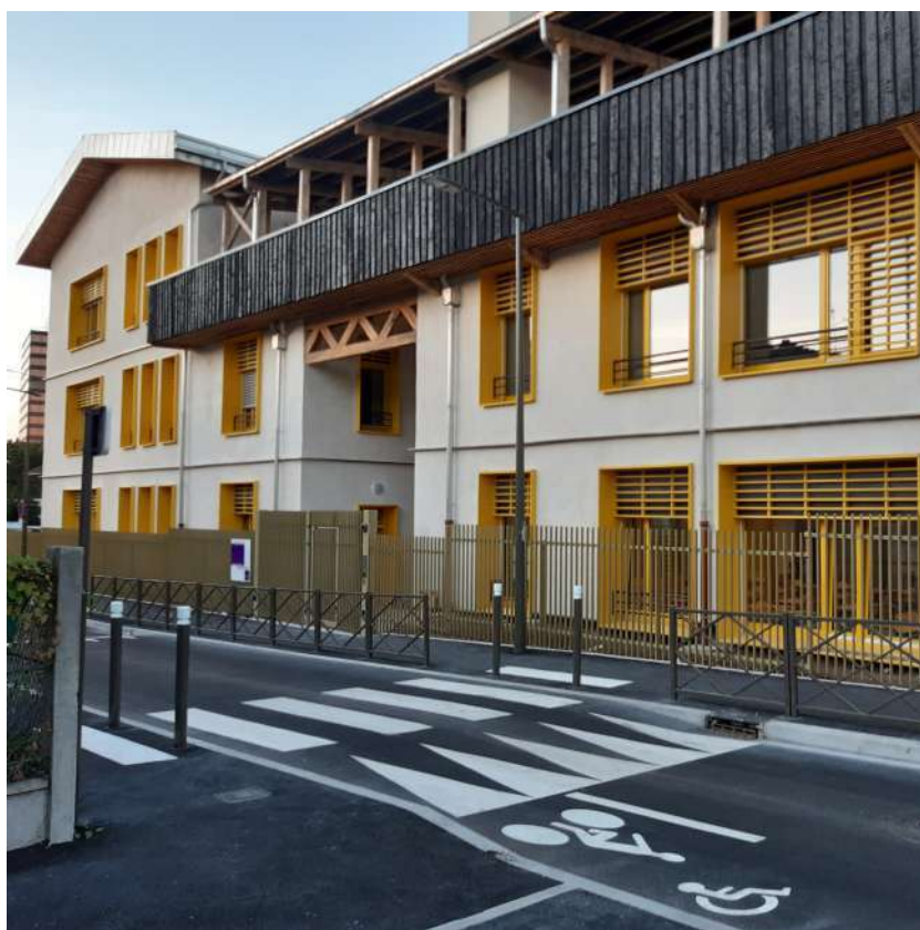
Bardage bois brûlé. Façade groupe scolaire Simone Veil. Rosny-sous-Bois. 2021. © Direction Recherche et Innovation
