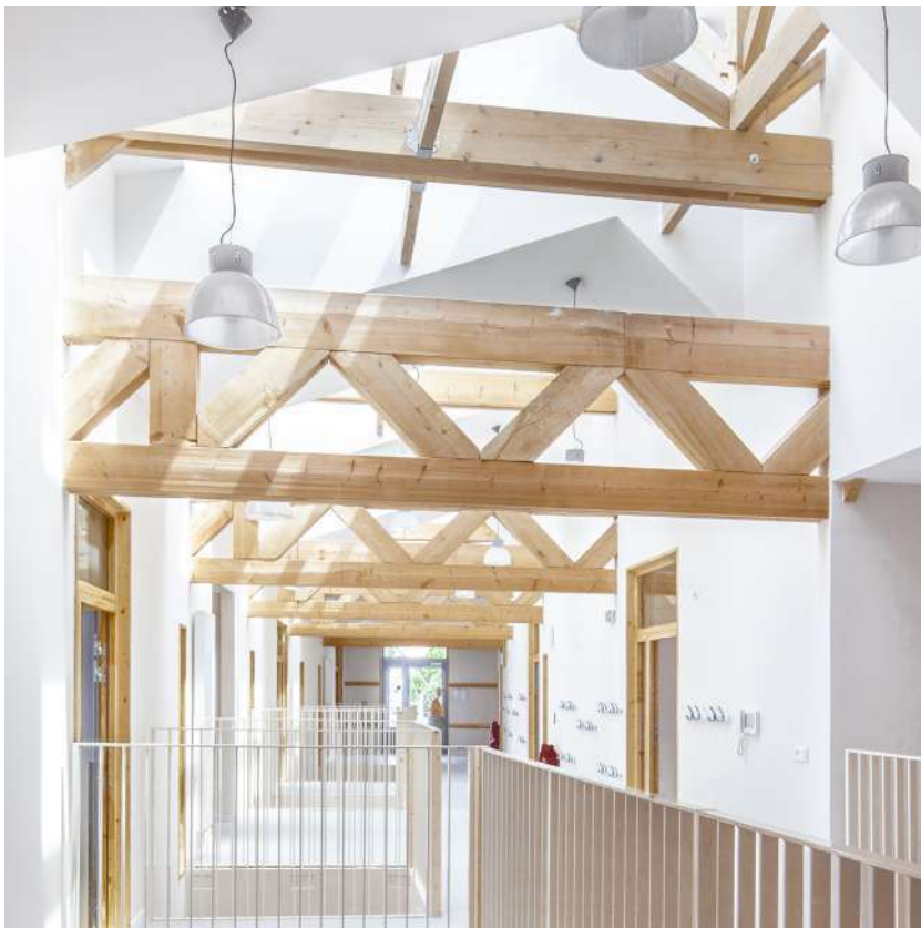
Poutres treillis. Groupe scolaire Simone Veil. Rosny-sous-Bois. 2020. © Juan Sepulveda
