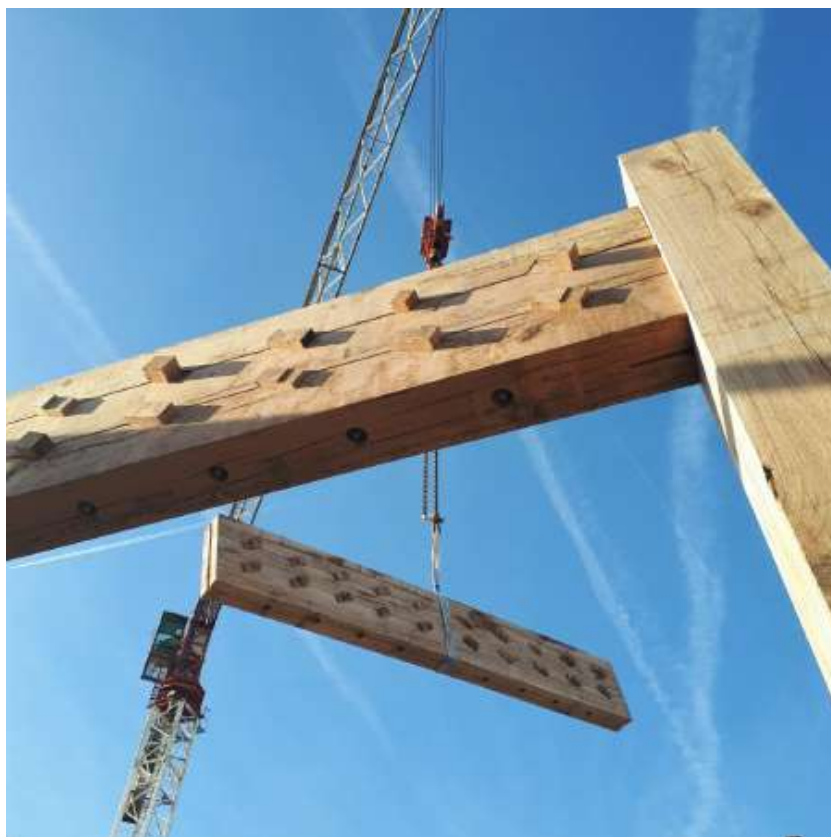
Groupe scolaire Rosny Métropolitain . Poutres clavetées en chêne massif. Phase chantier. Février 2020. © Ville de Rosny-sous-Bois
