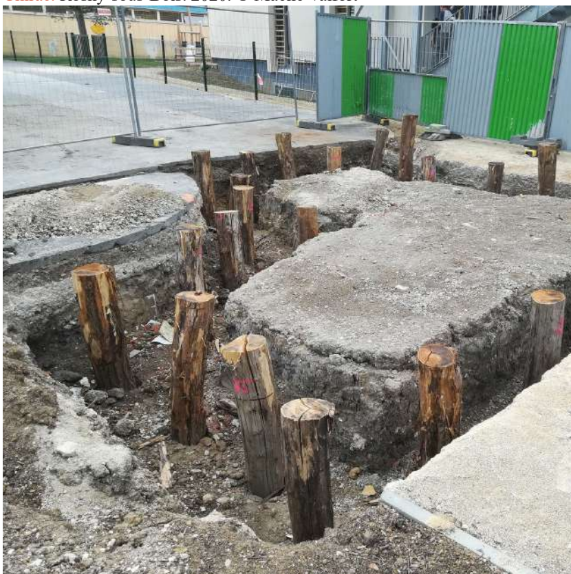
Fondations pieux de robinier. Local vélo du centre de loisirs Jacques Chirac. Rosny-sous-Bois. 2020. © Maëlle Valfort
