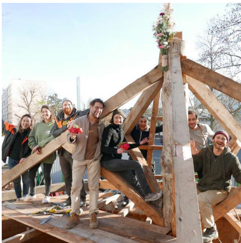
Construction de la charpente d'un local vélos. Chantier participatif citoyen. Centre de loisirs Jacques Chiract. Rosny-sous-Bois. Mars 2021. © Maëlle Valfort
