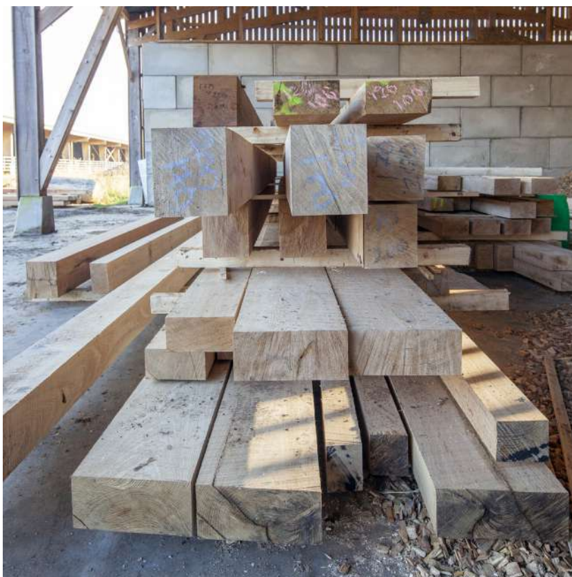
8. Stockage à l'abri des pièces sciées pour les préaux © Juan Sepulveda
