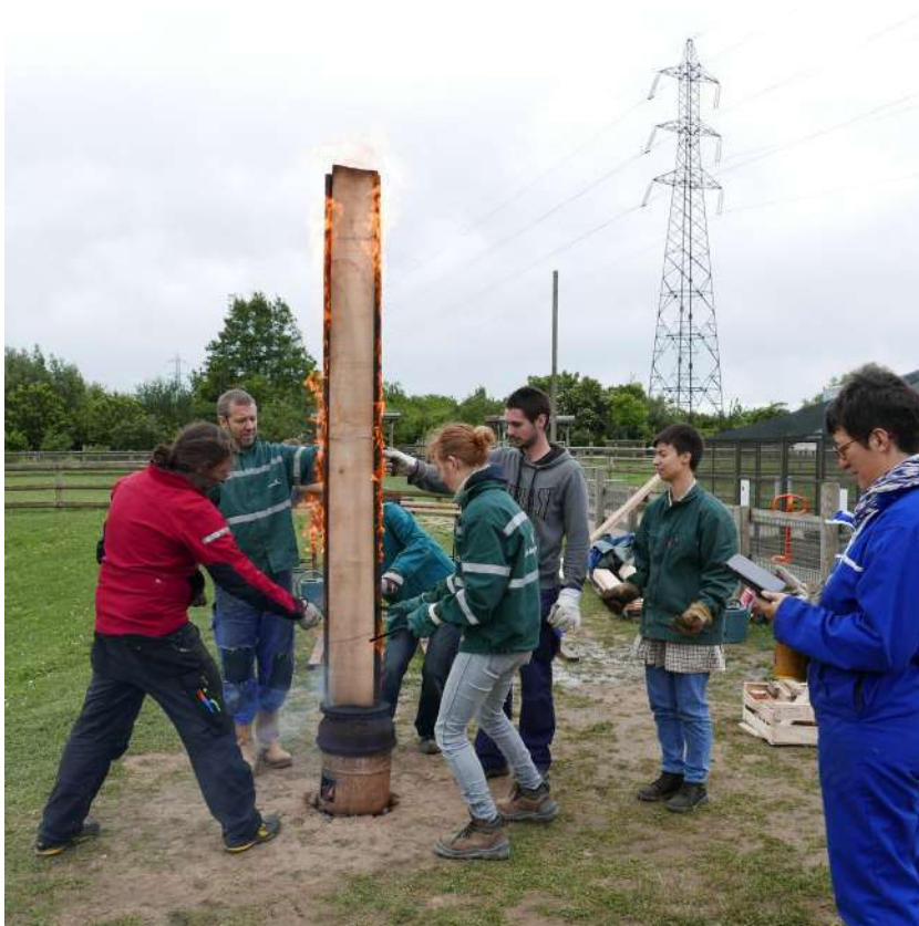
Technique Shou Sugi Ban. Chantier participatif citoyen. Centre de loisirs Jacques Chirac. Rosny-sous-Bois. 2021. © Maëlle Valfort
