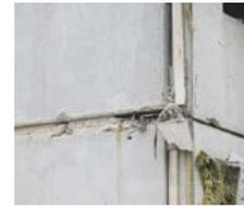
Plan d'étage courant et détail d'assemblage de deux panneaux et d'un plancher, on peut constater la présence de 3 cm d'isolant. A droite photo de la démolition, décembre 2015
