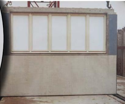
Photo d'un panneau de façade en sortie d'usine prêt à l'emploi, archive OPH
