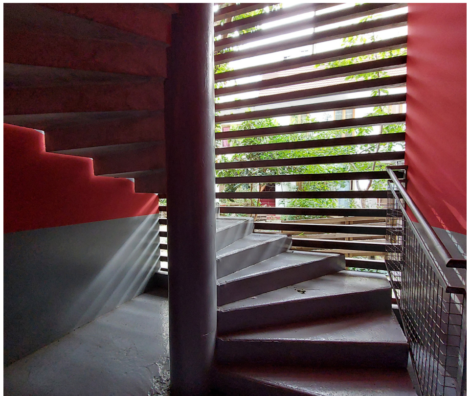
Colonne d'escalier ouverte sur le jardin par des claustras bois © CAUE de Paris - 2023
