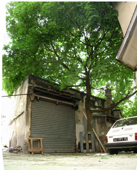
Parcelle initiale insalubre - 2003 © KOZ architectes
