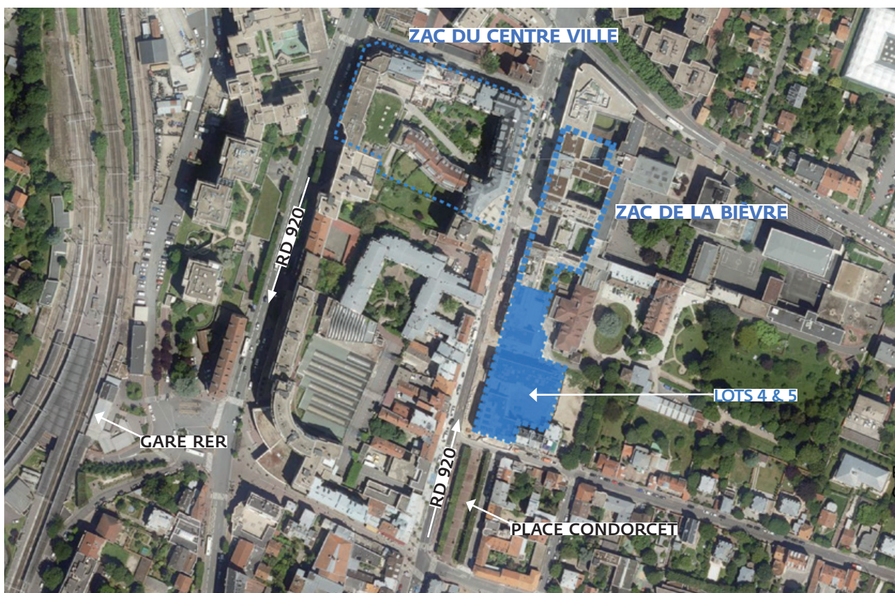
Situation des lots 4&5 de la ZAC de la Bièvre dans le centre ville de Bourg la Reine
