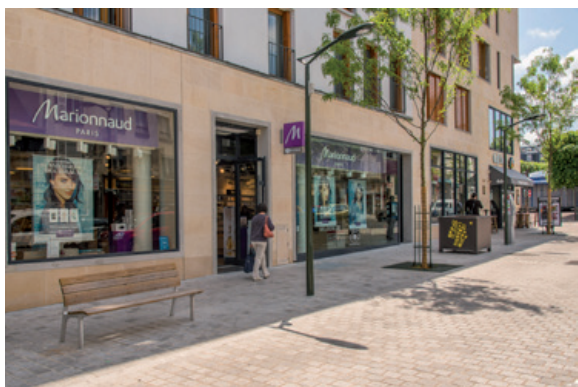
Vue sur le soubassement du rez de chaussée depuis la RD960. Crédit : Fabrice Boissière
