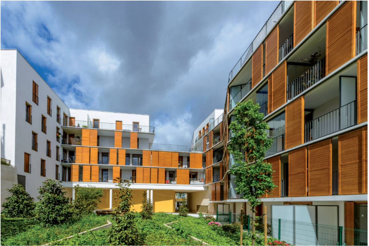
Vue sur le coeur d'îlot et sur l'allée végétale. Crédit : Fabrice Boissière
