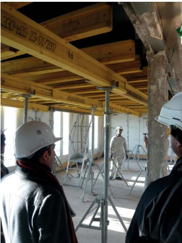
Renforcement des planchers en cours de chantier.
